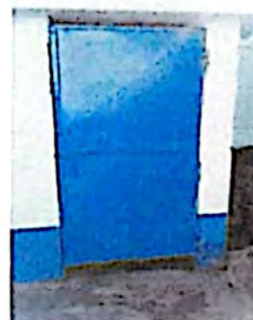
Foto 4: Mantenimiento de puertas de baños finalizado
