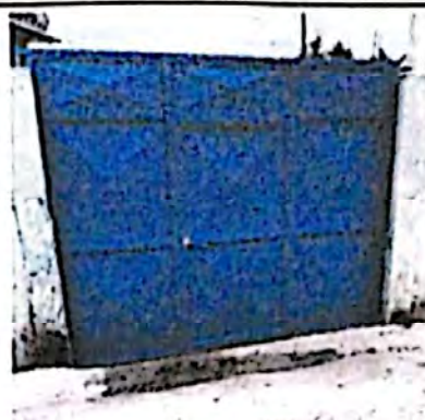
Foto 2: Porton del establecimiento ya colocado
